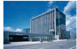
ワイズマン盛岡本社ビル
